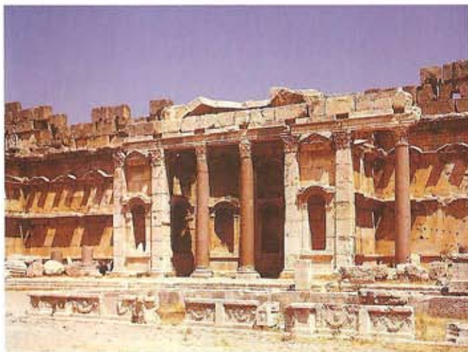
Las exedras del gran patio.
